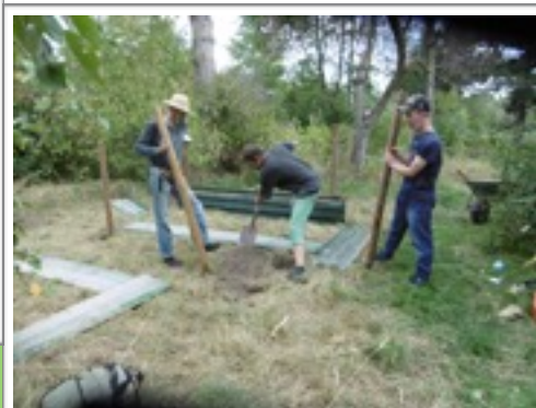
Bau eines neuen Kompostplatzes
